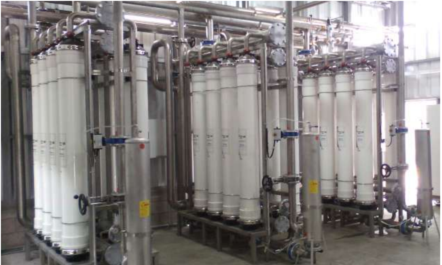
MODULOS DE ULTRAFILTRACIÓN INSTALADOS EN PLANTA DE RECUPERACIÓN DE AGUAS
