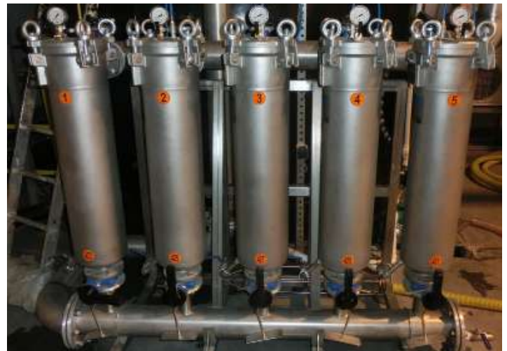
EJEMPLOS DE CESTOS RETENEDORES DE DIFERENTES MEDIDAS Y TAMAÑOS FILTERS EN FÁBRICA DE SPUNLACE
