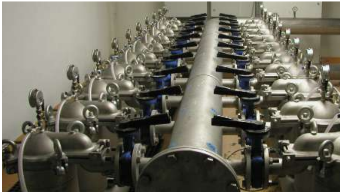
EJEMPLOS DE CESTOS RETENEDORES DE DIFERENTES MEDIDAS Y TAMAÑOS FILTERS EN FÁBRICA DE SPUNLACE
