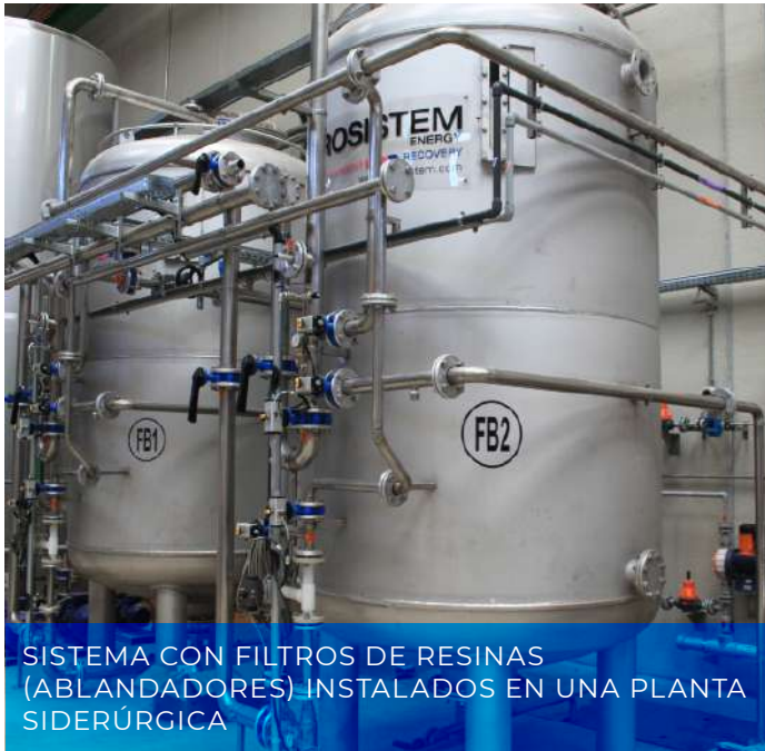
SISTEMA CON FILTROS DE RESINAS (ABLANDADORES) INSTALADOS EN PLANTA DEL SECTOR SPUNLACE
